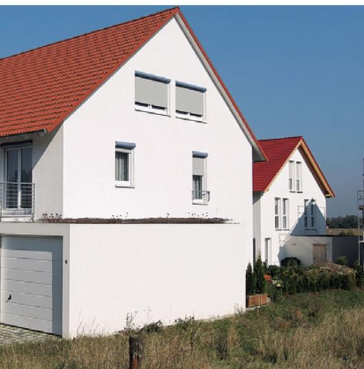
Betonfertiggeragen bieten sich besonders für extensive Dachbegrünung an, da sie ohne einen zusätzlichen Aufbau und nur mit einer dafür ausgelegten Dacheindichtung zu bepflanzen sind.
